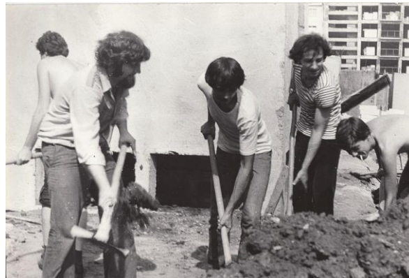
Studenți în practică pe șantier
